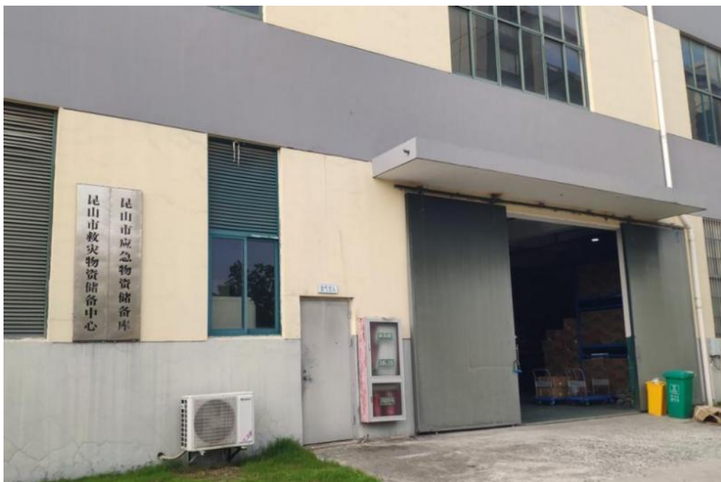
图3-1 昆山市应急物资储备库
